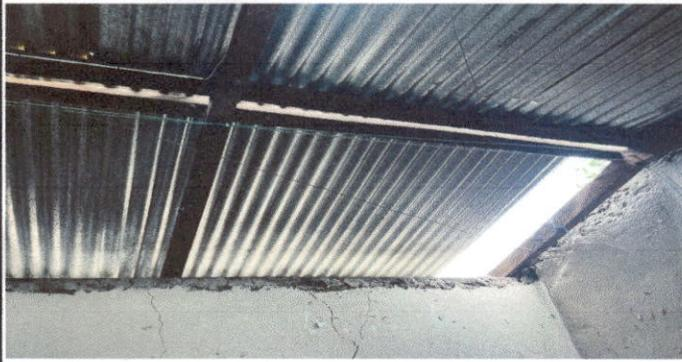
Foto1: Sustitucion de techo de madera por metal y lamina troquelada
