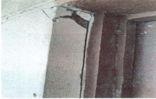
Foto1: Sustrucción de Puerta de madera por metal
